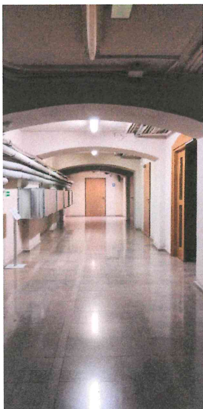
Zdjęcie nr 31 i 32. Obniżenie wysokości korytarza na drodze ewakuacyjnej na parterze
