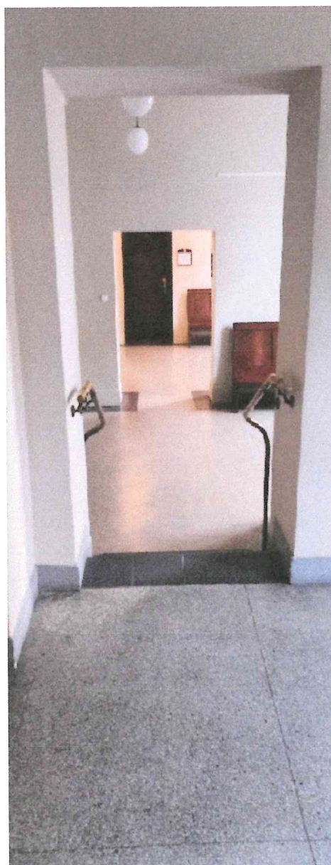
Zdjęcie nr 30. Przewężenie na drodze ewakuacyjnej na parterze
