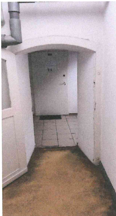
Zdjęcie nr 37. Szerokość drzwi prowadzących na klatkę KS5 wynosi 0,77 m.
