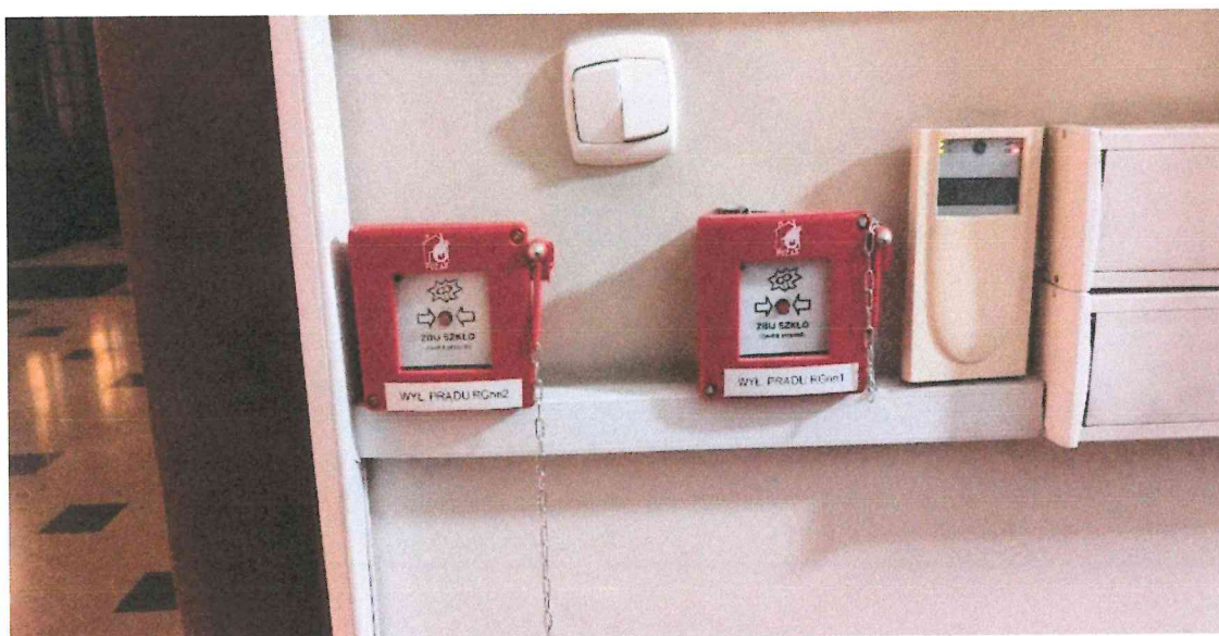
Zdjęcie nr 44. Przyciski przeciwpożarowego wyłącznika prądu.
