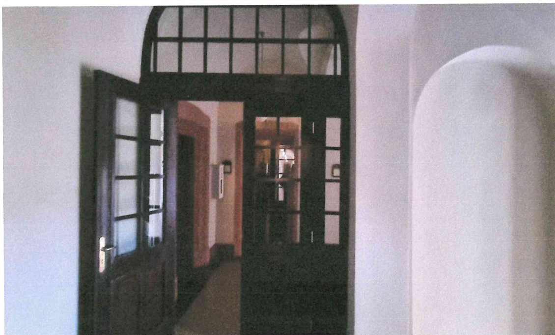
Zdjęcie nr 35 i 36. Korytarz przedzielony drzwiami bez parametru dymoszczelności.
