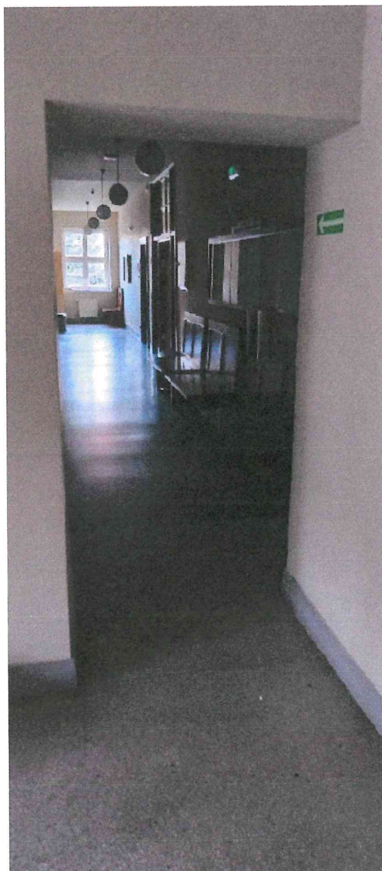
Zdjęcie nr 29. Przewężenie na drodze ewakuacyjnej na parterze
