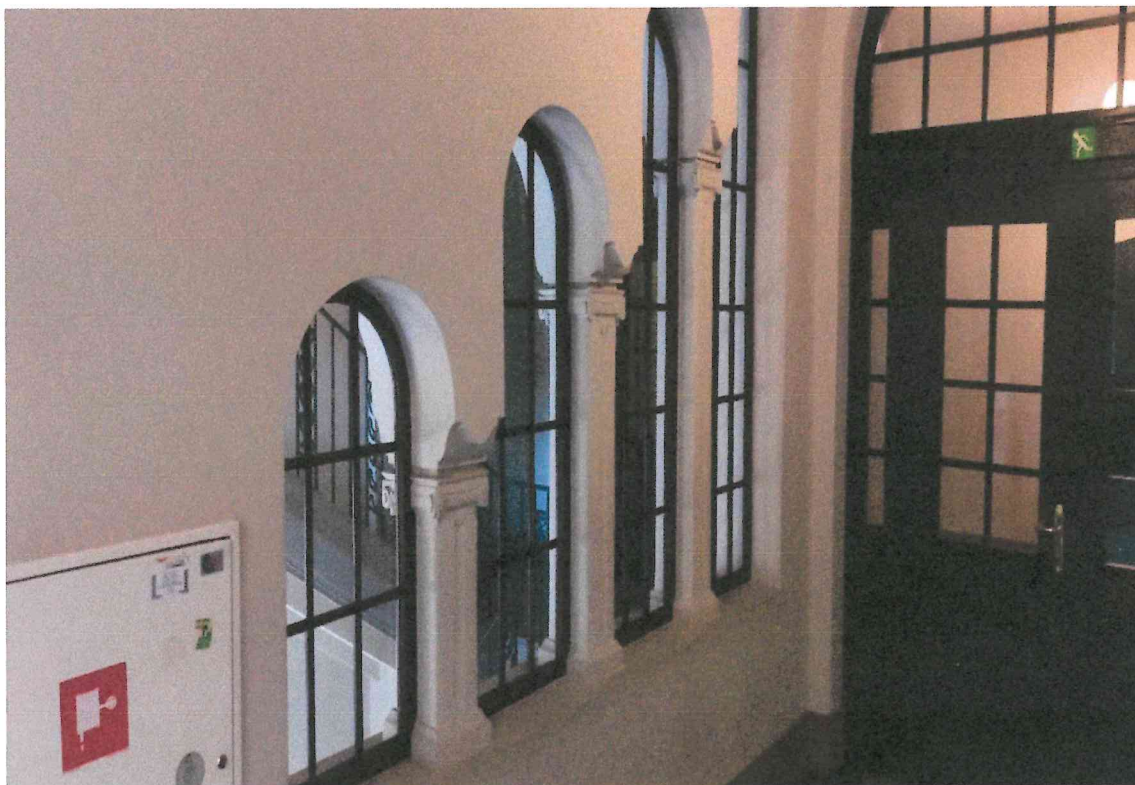
Zdjęcie nr 34. Przeszklenia pomiędzy klatką schodową KS2 a korytarzem bez odporności ogniowej.
