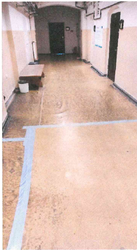
Zdjęcie nr 41 i 42. Wykładziny podłogowe PCV bez potwierdzonego parametru trudno zapalności.
