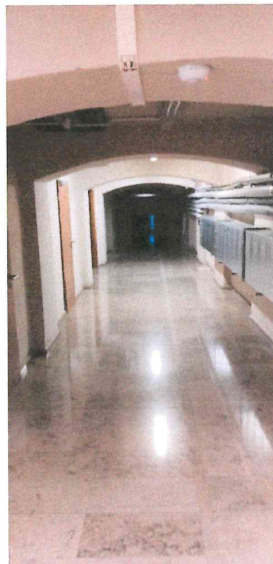
Zdjęcie nr 31 i 32. Obniżenie wysokości korytarza na drodze ewakuacyjnej na parterze
