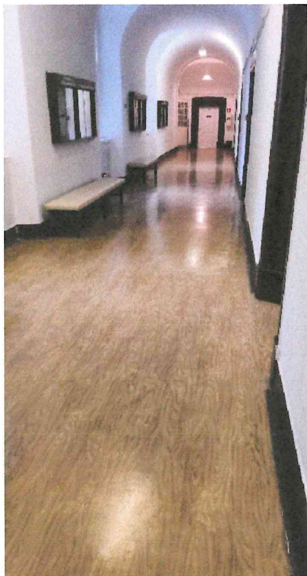
Zdjęcie nr 41 i 42. Wykładziny podłogowe PCV bez potwierdzonego parametru trudno zapalności.
